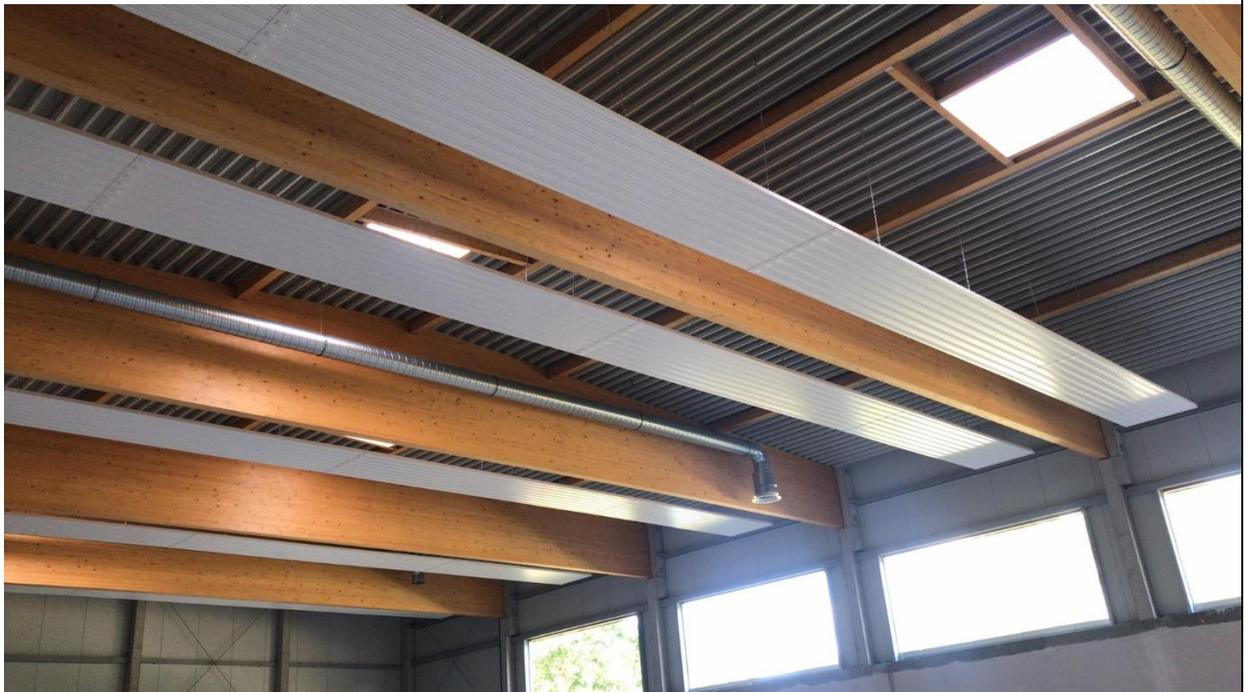
Dachkonstruktion mit Deckenheizung und Lüftungskanäle
