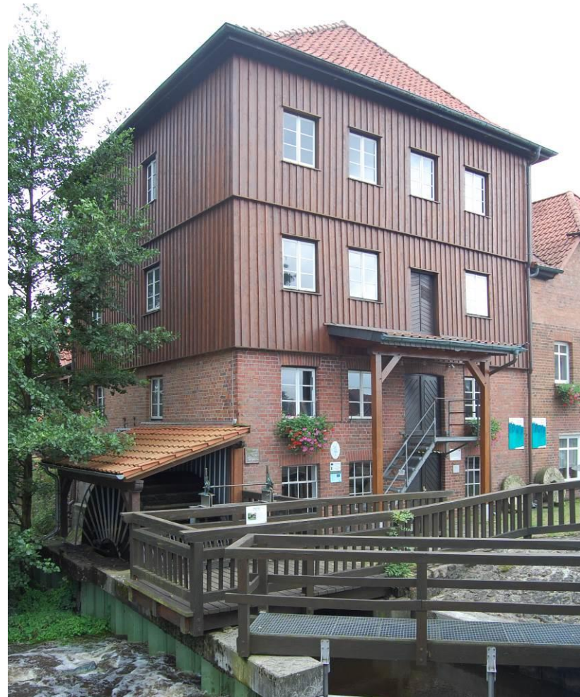
Abb. 20: Sanierte Wassermühle Wahrenholz an der Ise
