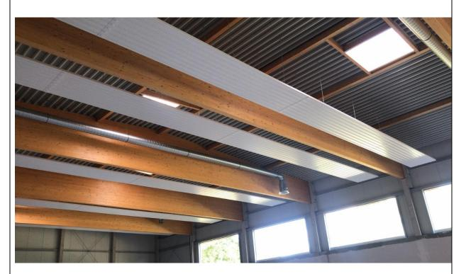
Dachkonstruktion mit Deckenheizung und Lüftungskanäle
